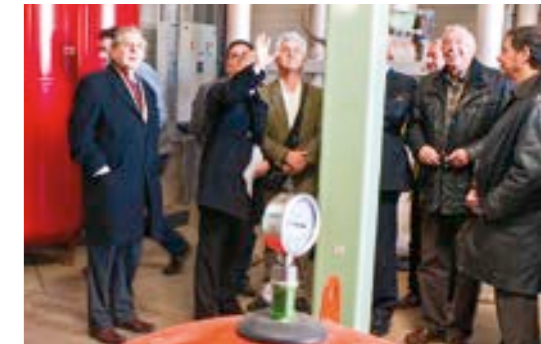
Réseau de chaleur mis en place entre Souleyrie et le Centre Aquatique
