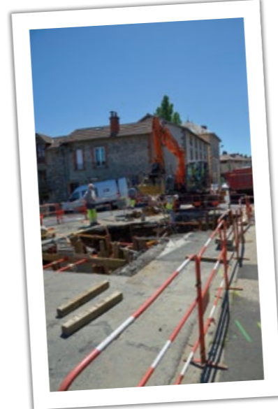
Dès la fin avril, les chantiers sur les réseaux d'eau et d'assainissement ont été relancés.
